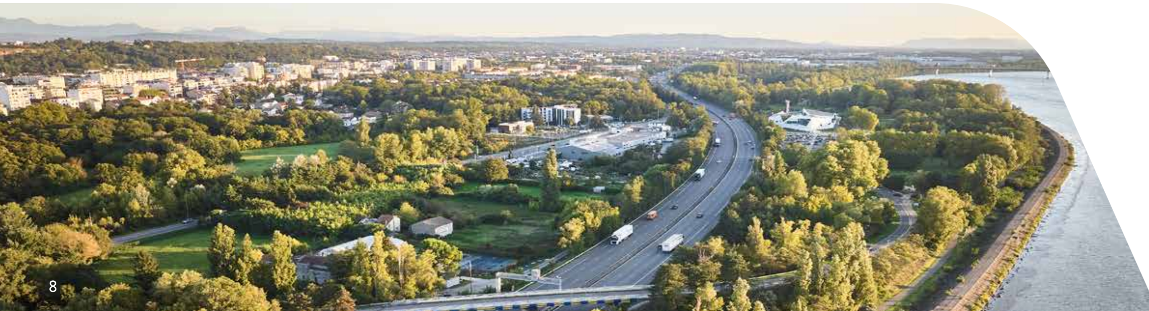
Vue aérienne de l'A7 au niveau du pont du chemin de l'Épervière
