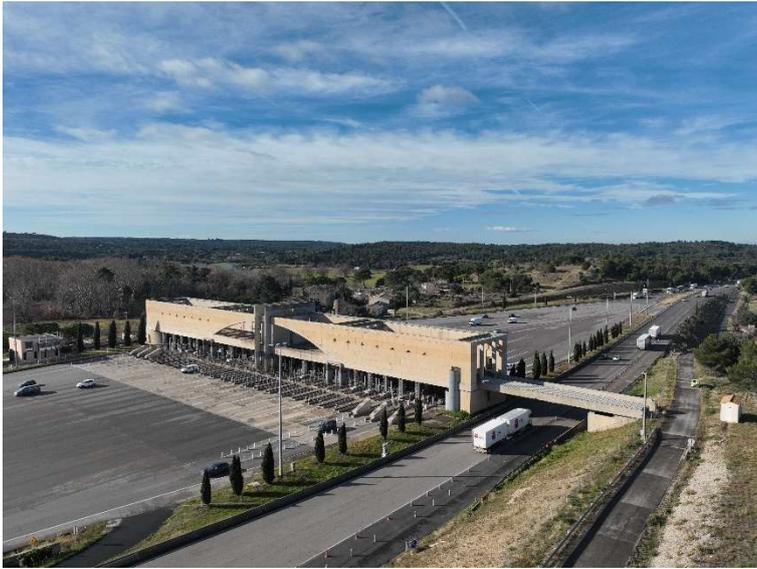
Dans le sens Lyon-Marseille : l'auvent s'étend sur 140 mètres de long et 15 mètres de large. Il est constitué d'un hourdis en béton, d'une structure architecturale en macro-parpaings intégrant deux arches symétriques, le tout reposant sur deux poutres longitudinales en béton entretoisées.
