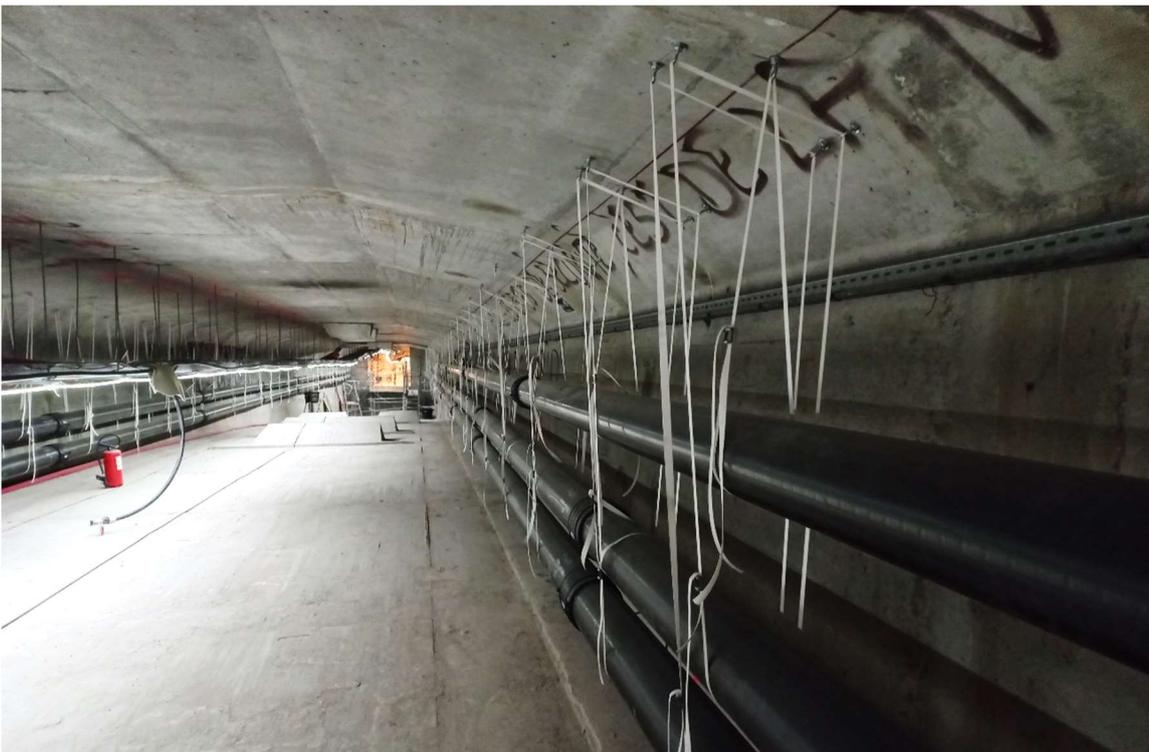
*Précontrainte additionnelle mise en œuvre sur le Viaduc de Vienne Sud (2023-2025) Image JP Moulet*
