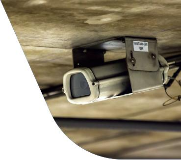
**Les caméras de vidéosurveillance** permettent aux agents d'exploitation du tunnel de détecter très rapidement tout incident.
