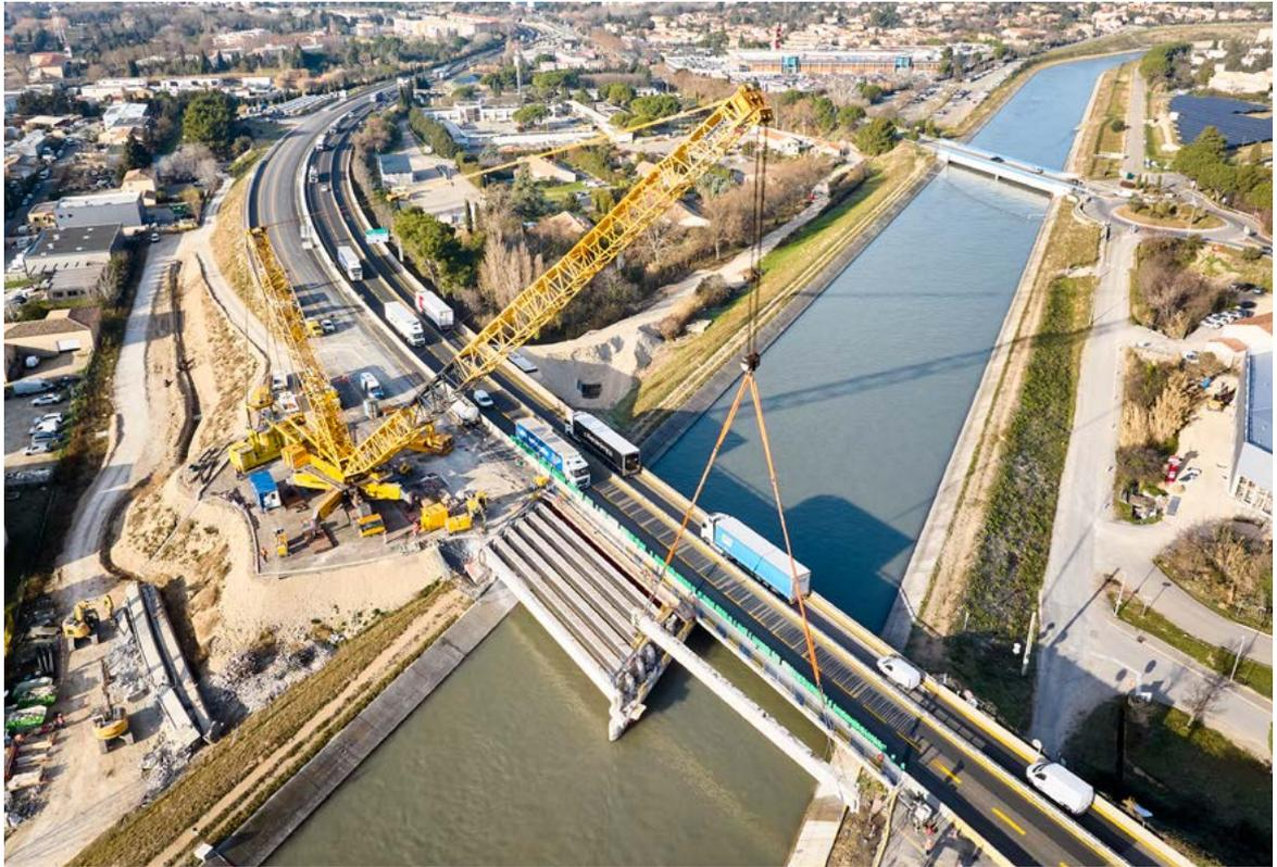
*Remplacement du pont qui enjambe le canal EDF sur A54 à Salon-de Provence. Les poutres de l'ouvrage ont été déposées et concassées sur place. Elles sont recyclées à 100 % (béton et acier).*
